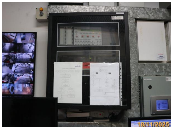
รูปที่ 3-38 Fire Alarm Control Panel
