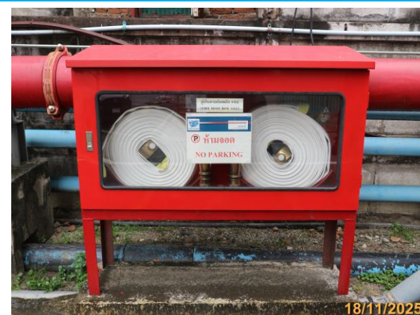
รูปที่ 3-41 ตู้เก็บสายน้ำดับเพลิงพร้อมอุปกรณ์
