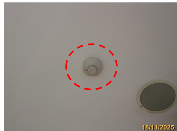
รูปที่ 2.9-2 Smoke Detector
